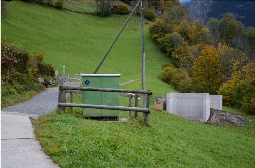
*Die beiden Wiederlager für die neue Brücke über den Mehlbach vom Grottenweg stehen. Die neue Brücke ist nur unwesentlich von der bestehenden Brücke entfernt.*
