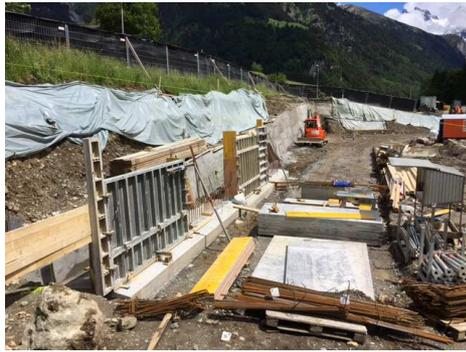
Ebenfalls Gestalt an nimmt der Bau der Verbindungsrampe vom mittleren zum obersten Friedhofteil. Die Hangsicherung ist gut vorangekommen und nun werden die Schalungen für die neuen Mauern der Rampe installiert. Diese Rampe ermöglicht im fertigen Zustand einen rollstuhlgängigen Zugang zum mittleren Friedhofteil vom Verbindungsweg Schulhaus-Ochsenmatte her.
