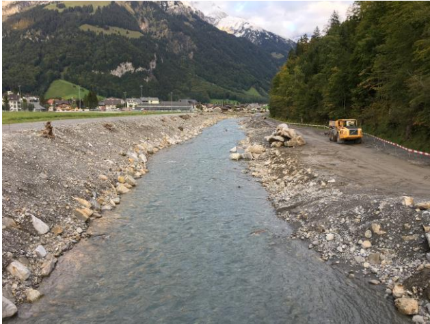
Blick von der Rohrbrücke abwärts, Bauarbeiten abgeschlossen
