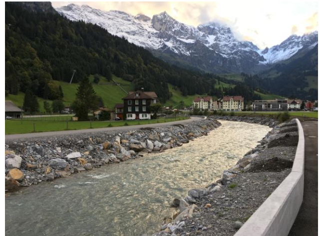
Blick vom Bänklialpweg aufwärts, Bauarbeiten noch im Gang
