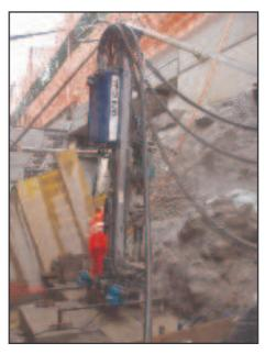
schwierigen Baugrund konnten Bohrleistungen (siehe Bild) von 25 Metern pro Tag erreicht werden. Dabei wurden Gewindestäbe mit einem Durchmesser von 35 bis 63,5 mm eingebaut. Beim diesem Einbau wurde die Gelegenheit benutzt, Elemente wie Inklinometer und Druckmessdosen einzubauen, um den Hang und die Kunstbauten zu überwachen. Die bisherigen Messungen haben bislang keine Hinweise auf Bewegungen im Baugrund ergeben.
