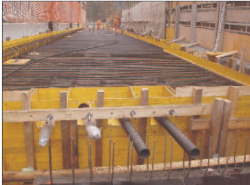
Ein letzter Blick auf die Armierungen, bevor der Beton beim Lehnenviadukt eingebracht wird.
