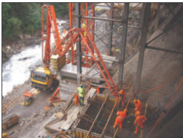
Bei all den Arbeiten muss die Bauleitung immer wieder die verschiedenen Werkleitungen in die Überlegungen mit einbeziehen. Beim nordseitigen Brückenteil musste die Aufhängung eines Werkleitungsblocks der Strassenentwässerung an die bestehende Brückentrogplatte montiert werden.
