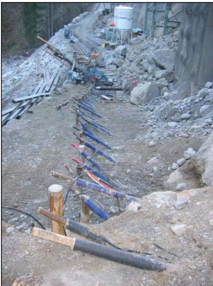
Der Hangfuss musste mit Anker gesichert werden.
