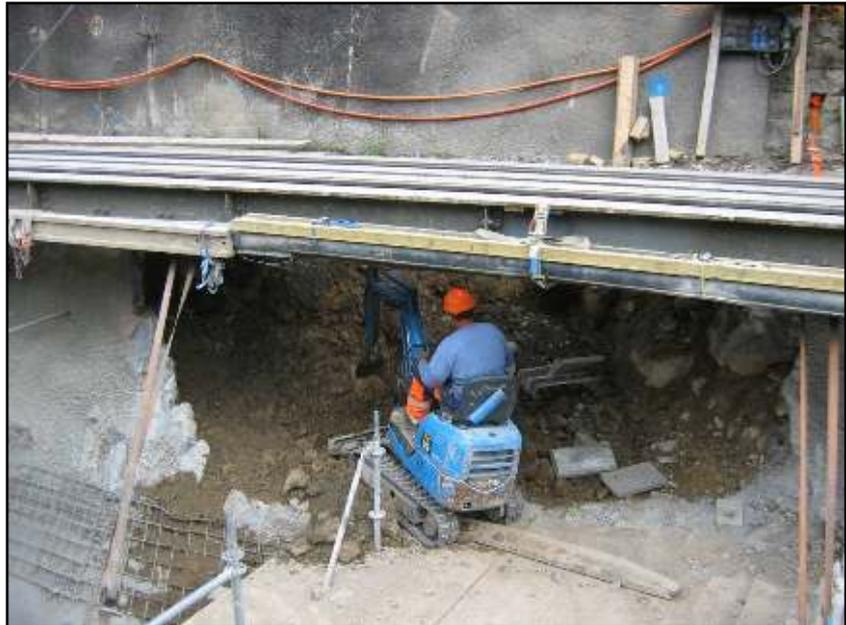
In der letzten Woche konnten die Bohrarbeiten für die Prüfananker abgeschlossen werden. Diese können somit in den kommenden Tagen eingesetzt werden. Zur Hangsicherung kam erneut Spritzbeton zum Einsatz. Nachdem auch das Gerüst im Bereich der Bahnrippe fertig aufgebaut werden konnte, kann demnächst der definitive Bau der Bahnrippe in Angriff genommen werden.
