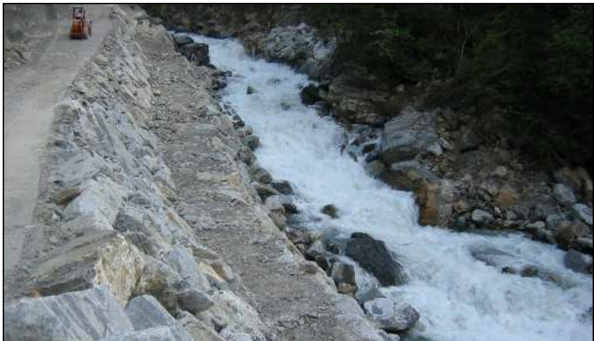
Die Engelbergeraä in ihrem angestammten Bachbett. Links die neu erstellte Ufersicherung.
