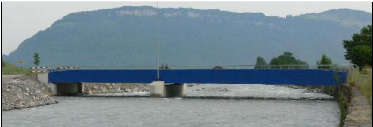
Die Bürer-Brücke. Der Mittelpfeiler steht am Standort des früheren linken Ufers.
