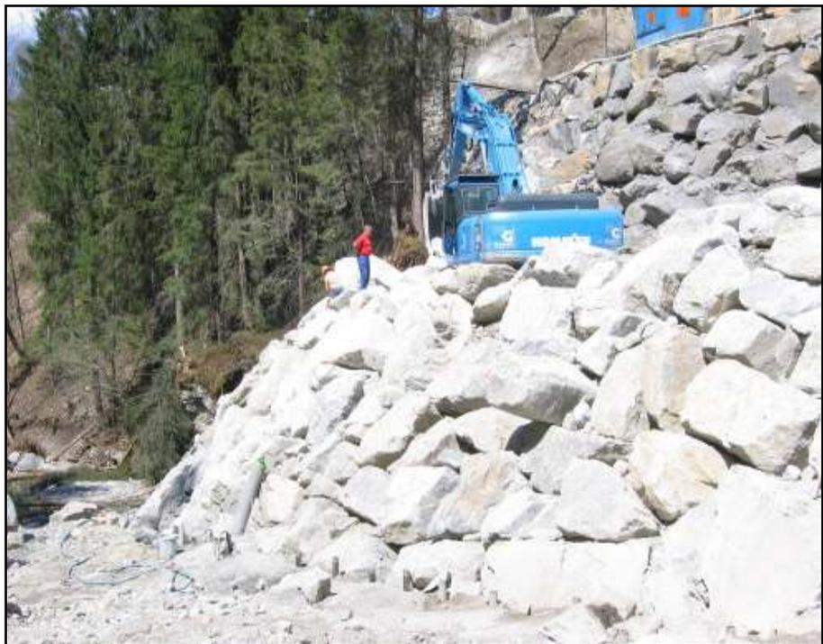
der vorliegenden Terminplanung bis Mitte Juni 2006 ausgeführt sein. „Die Erstellung des Blocksatzes im Bereich der Viaduktstützen drei bis sieben (siehe Bild) ist grösstenteils fertig erstellt“, so Roger Waser. Noch in Arbeit ist der so genannte Unterkolkungsschutz, den die Fachleute auch als Rohrschirm bezeichnen. Die Gestaltung der Bachsohle im unteren Abschnitt erfolgt zirka ab Mitte Mai.
