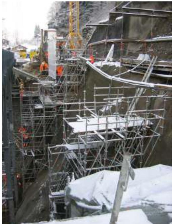
Parallel zu den Strassenbrücken wird ebenso intensiv an den Bahnrippen gearbeitet. Es bleibt das ehrgeizige Ziel aller am Bau beteiligten, dass die Zentralbahn ebenfalls am 15. Dezember 2005 wieder in Engelberg einfahren wird. Die Sicherungsmassnahmen an den bestehenden Viaduktstützen werden vorangetrieben. Ebenso die Arbeiten für den Hochwasserschutz, der jetzt bei tiefem Wasserstand trotz Schnee und Kälte ausgeführt werden muss.
