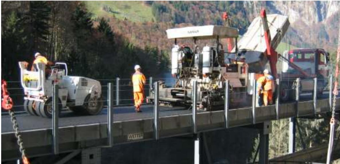
Belagseinbau bei der ersten Hilfsbrücke.
