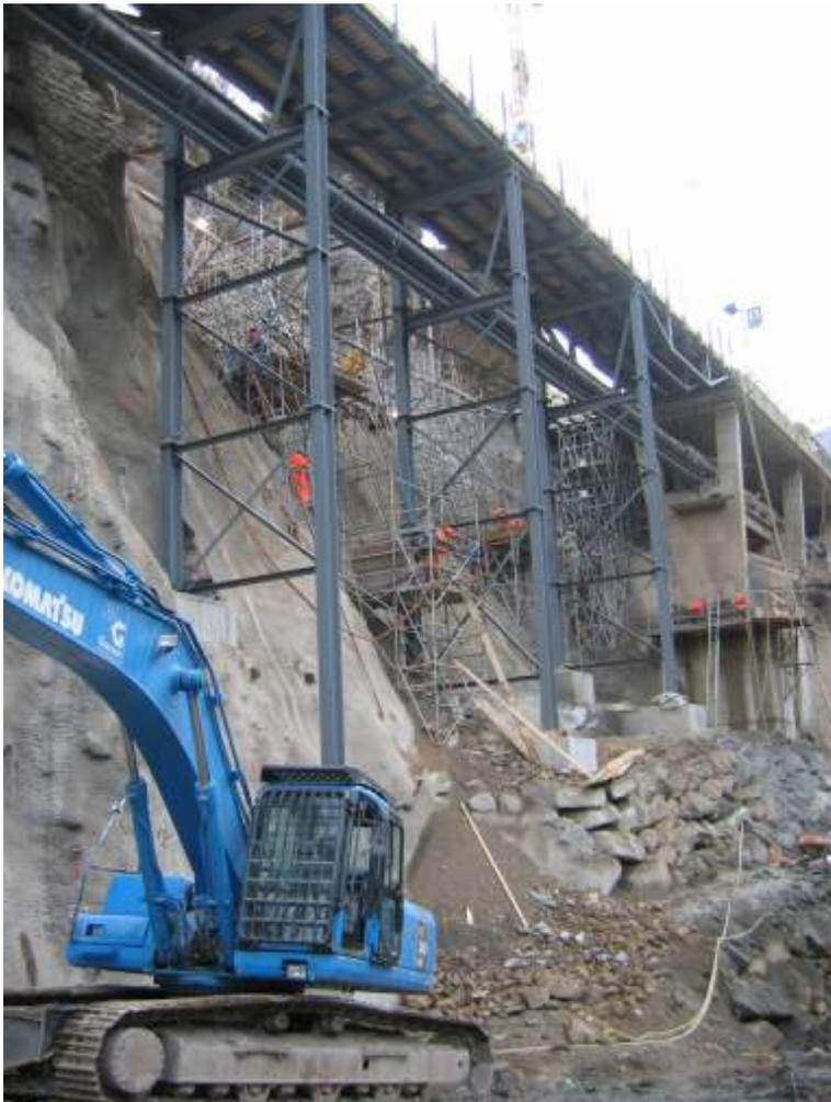
Der Blick vom Bachbett der Engelbergeraai zeigt die Metallkonstruktion der ersten Strassenbrücke mit der Kanalisationsleitung.
