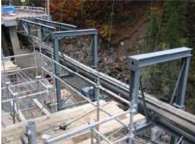
Stahlstützen (Bild) für die erste Strassenbrücke. In Angriff genommen wurden die Aushubarbeiten für die zwei mittleren Bahnrippen. Zurzeit werden die Bauarbeiten am Lehnenviadukt zusammen mit dem Stahlbau im Drei-Schicht-Betrieb ausgeführt. Das heisst: es wird rund um die Uhr gearbeitet. Und noch eine gute Nachricht vom Einwohnergemeinderat: Eine Delegation des Rates hat in Sarnen erwirkt, dass auch die zweite Brücke pünktlich auf die neue Winter-
