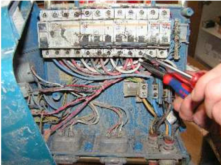
Aufgrund des Hochwassers wurden die Elektroverteilungen, welche die Anschlusskästen des EWO und die Installationen in den unterliegenden Räumen wie Keller oder Garagen bewerkstelligen, zum Teil überflutet.
