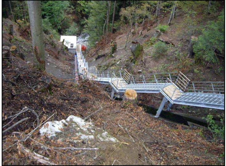
Die Wasserfassung beim Auslauf der ARA ist noch im Bau. Der Zusammenschluss mit der bereits montierten Druckleitung und der erdverlegten Druckleitung von der Wasserfassung bis zur Einstiegstreppe erfolgt in den nächsten zwei Wochen. Das Elektro- und Steuertableau, gebaut und ausgerüstet von der Firma Alro (diese ist spezialisiert auf Steuerungen und Automationen im Bereich Kleinwasserkraftwerke) ist fertig erstellt und werksseitig bereits getestet worden.
