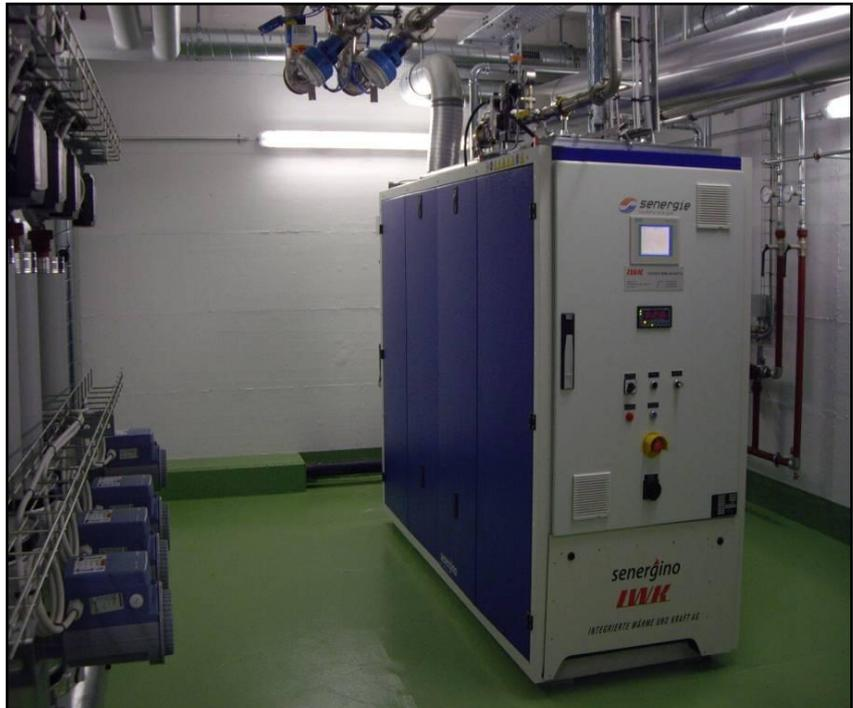
Generator, der aus Biogas grünen Strom produziert.
