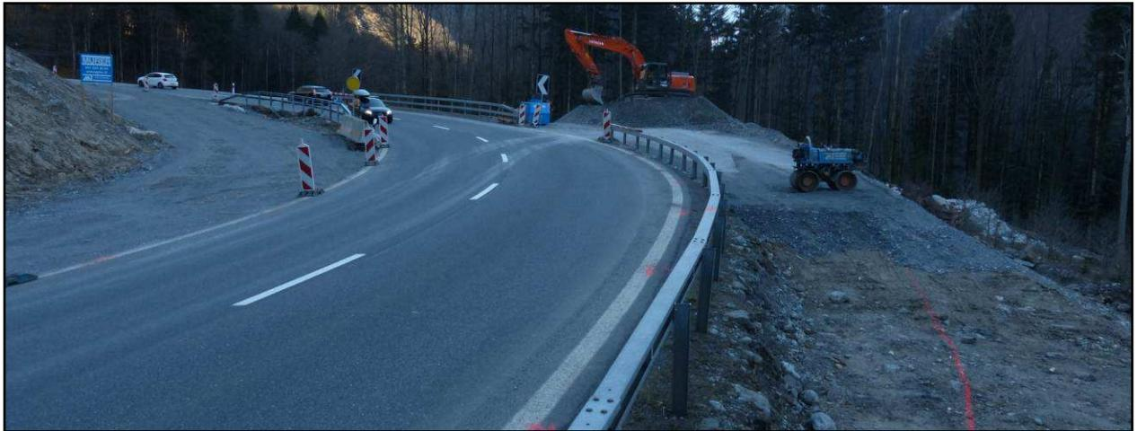
Am 11. April 2012 wird der Verkehr auf das provisorische Trasse (Bild links) umgeleitet. Die neue Streckenführung wird weiter rechts erfolgen. Die heute bestehende Fahrspur Richtung Engelberg wird dann die Talspur bilden.
