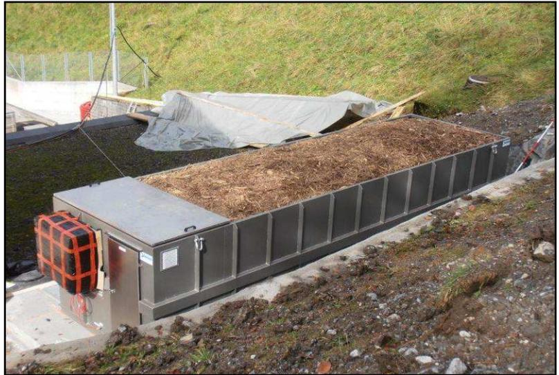
speziellem Altholz und Holzschnittzel befüllt. Das Holz wird mit einer integrierten Wasserberieselung immer feucht gehalten, damit die Microorganismen jederzeit ein optimales Umfeld vorfinden, um die kontaminierte Abluft zu reinigen. Die Wasserberieselung wird aus der betriebseigenen Wasseraufbereitungsanlage des gereinigten Abwassers betrieben. Die Abluftbiofilteranlage wurde so dimensioniert, dass zu einem späteren Zeitpunkt auch andere Abluftanlagen angeschlossen werden können.
